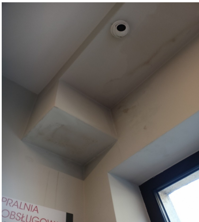
Pralnia - widoczne zawilgocenia nadproża i obudowy z płyt gipsowo-kartonowych
