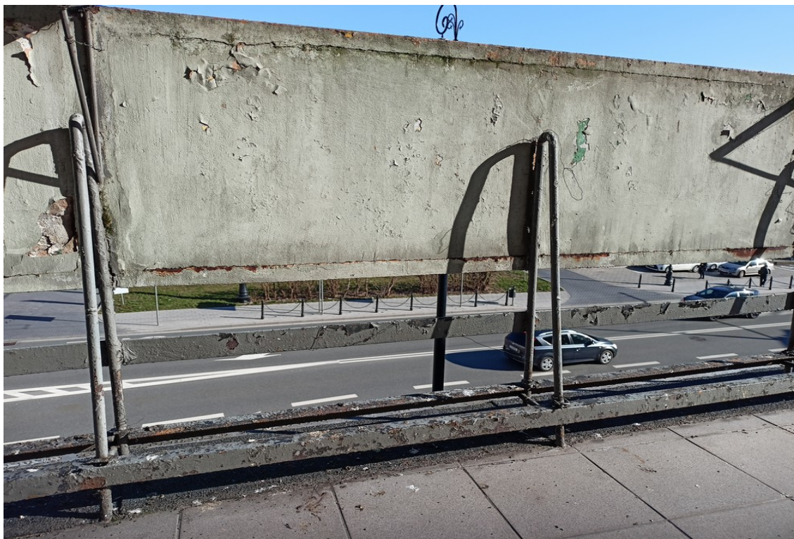
Taras - widoczne ubytki w wypełnieniu i ogniska korozji w konstrukcji balustrady
