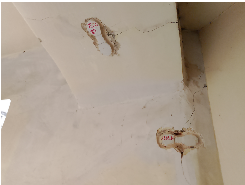
FOT.7. SPEKANIA ŁĘKU I ŚCIANY – I PIĘTRO
