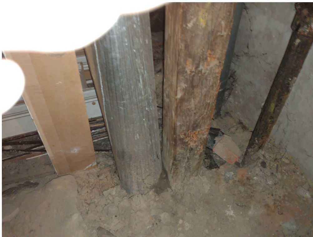
FOT.12. SKORODOWANIA KROKWI, PRZECIEKI POKRYCIA
