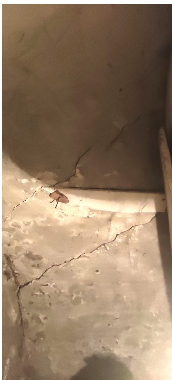
FOT.2. PĘKNIĘCIA SKLEPIENIA NAD PARTEREM
