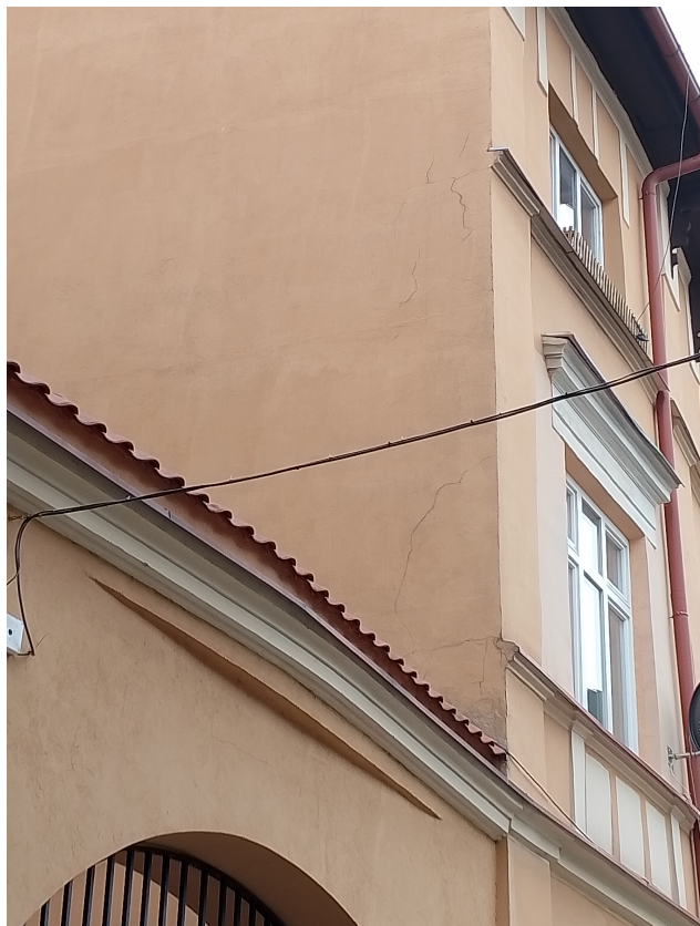
FOT.15. SPEKANIA NAROŻA ŚCIANY – ELEWACJA PÓŁNOCNA
