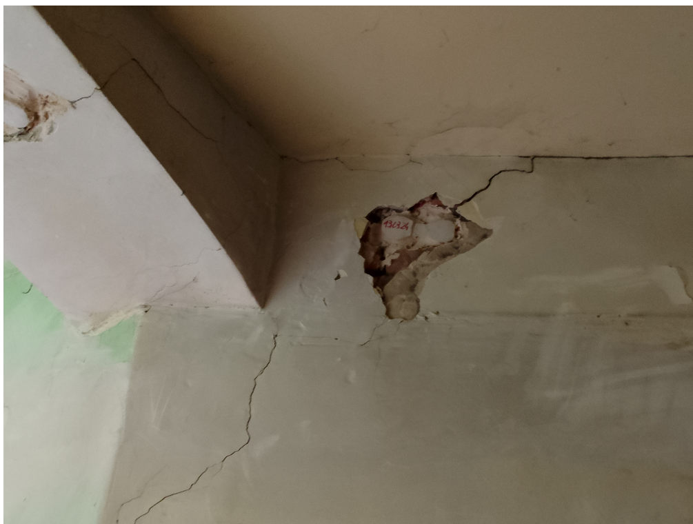
FOT.8. SPEKANIA ŁĘKU I ŚCIANY – II PIĘTRO
