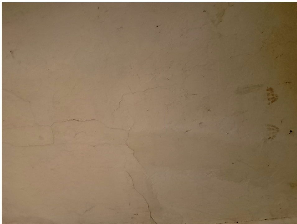
FOT.5. SPEKANIA SKLEPIENIA NAD PARTEREM
