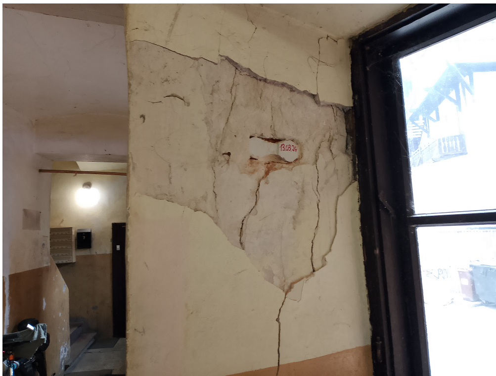
FOT. 4. SPEKANIA ŚCIANY POD OKNEM NA PARTERZE
