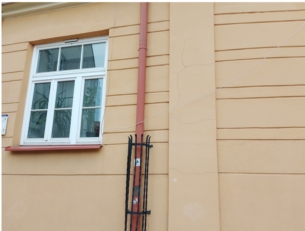
FOT.14. SPEKANIA ŚCIANY – ELEWACJA ZACHODNIA
