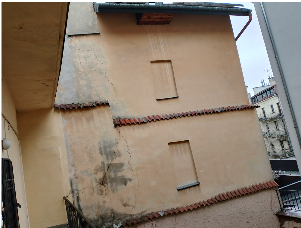
FOT.17. SPĘKANIA ŚCIANY (POZIOME) – EL. POŁUDNIOWA
