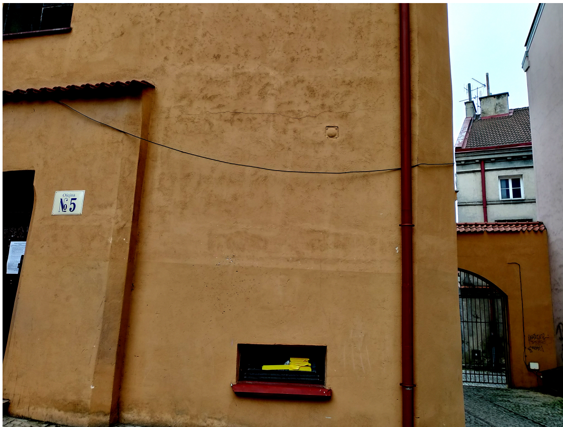
FOT.17. PĘKNIĘCIE ŚCIANY (POZIOME) – EL. WSCHODNIA
