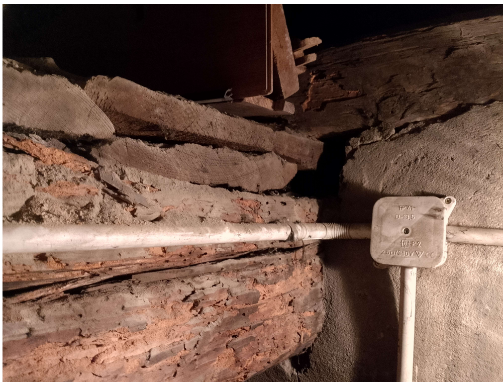
FOT.9. ZNISZCZONA BELKA STROPU PODDASZA NAD SCHODAMI
