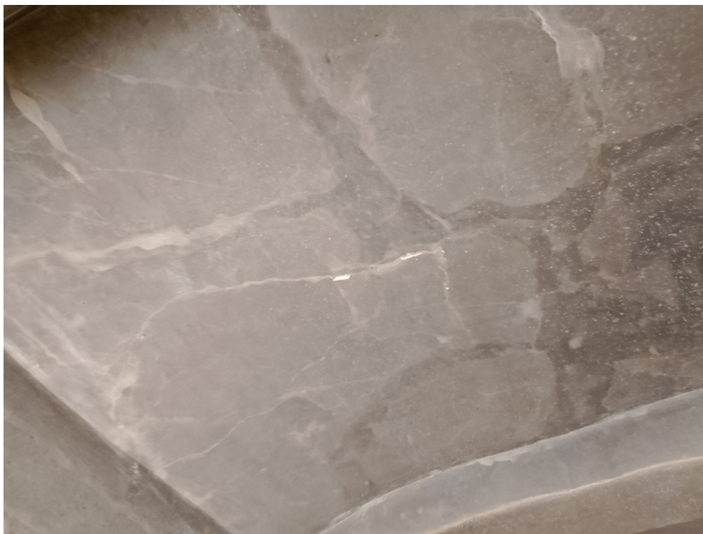
FOT.6. SPEKANIA, WYBRZUSZENIE SKLEPIENIA – I PIĘTRO
