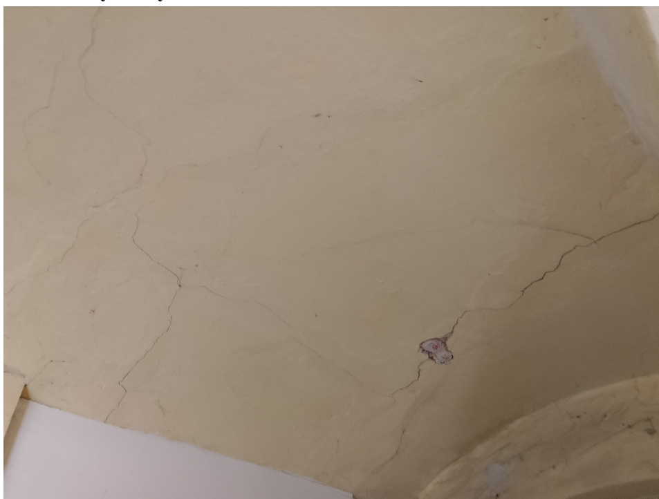
FOT.2. PĘKNIĘCIA SKLEPIENIA NAD PARTEREM
